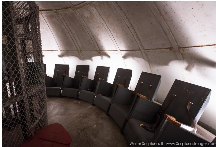
Fig. 10 Photographie de la "Rubber Room" (1963). Située sous le pas de tir des fusées américaines Saturn V, elle joue le rôle de bunker en cas d'anomalie au lancement (son nom provient des coussinets de caoutchouc qui devaient amortir une éventuelle déflagration 71 ). Les astronautes et le personnel au sol y ont accès au moyen d'un long toboggan. Source : scriptunasimages.wordpress.com
