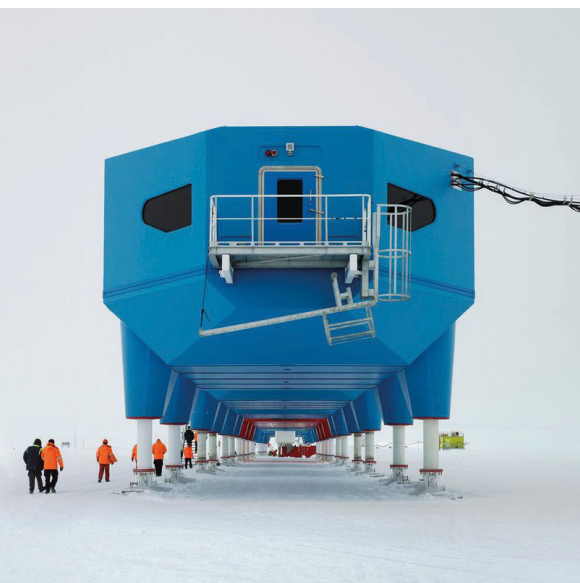
28. La base anglaise est surélevée pour faire face à l'accumulation de la neige
