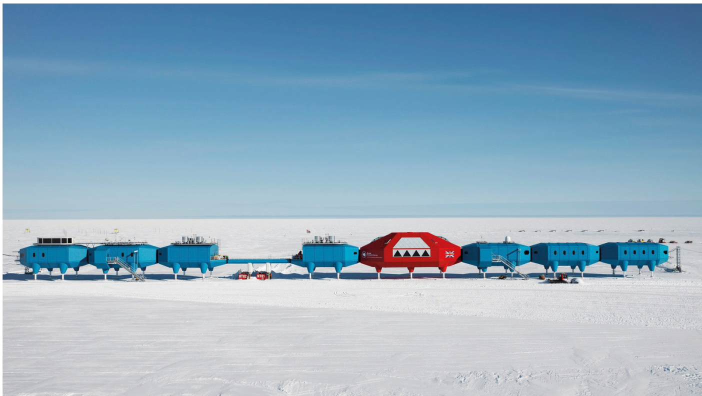
33. Vue globale de la base modulaire. Les espaces de vie et de contrôle sont à droite de la passerelle, tandis que les laboratoires se trouvent à gauche
